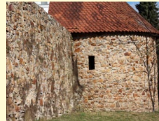
In der Region eher selten, in Weiden i.d. OPF. häufig zu finden, v.a. als Baustein der Stadtmauer: Permischer Rhyolith vom Fischerberg bei Theisseil.
